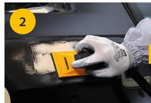
2 Da forma y nivela el rellenedor. Utiliza una tira de malla P80 o P120 con un bloque de lijar, o bien la máquina Mirka® OS 383 para las zonas más pequeñas.
